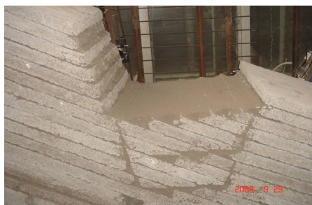
(a) 第 1 阶段开挖
